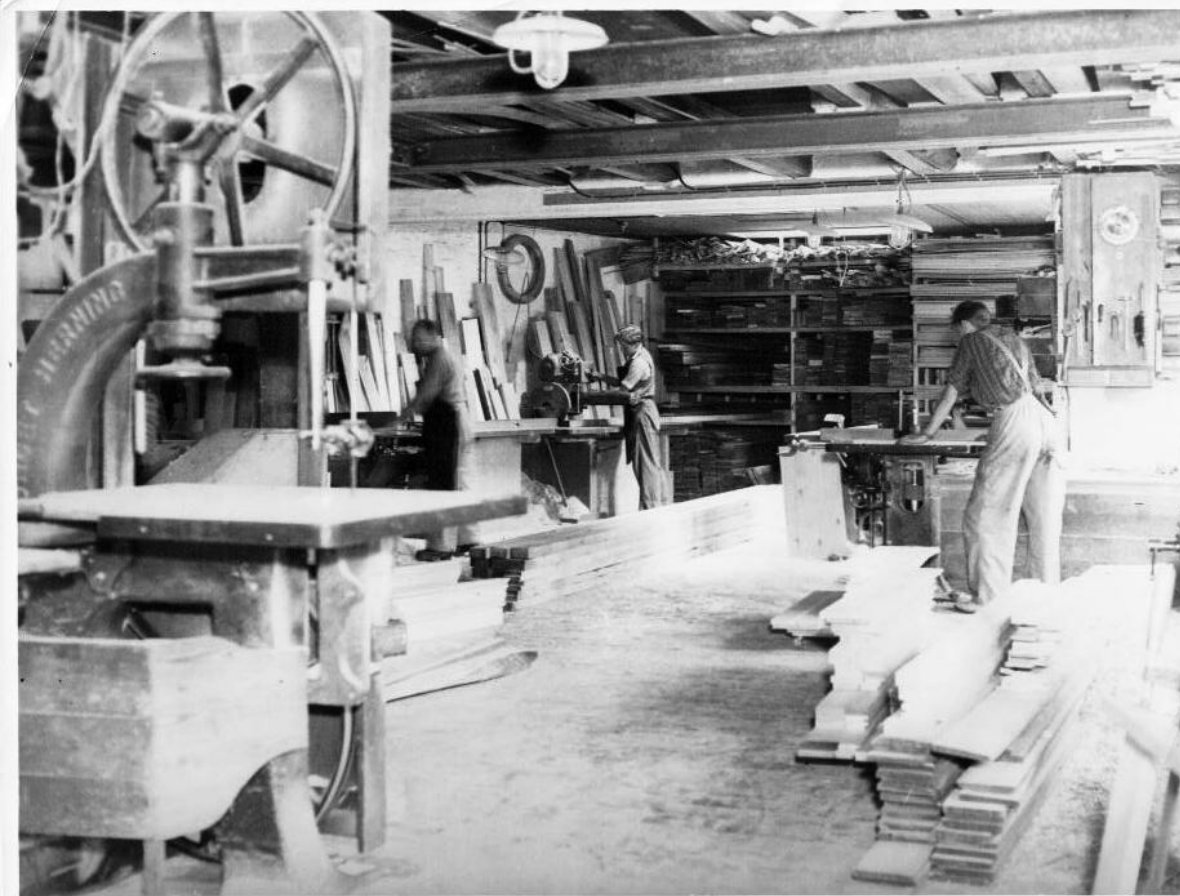
Billedet fra 1944. Der er det gamle maskinsnedkeri i buerne.
